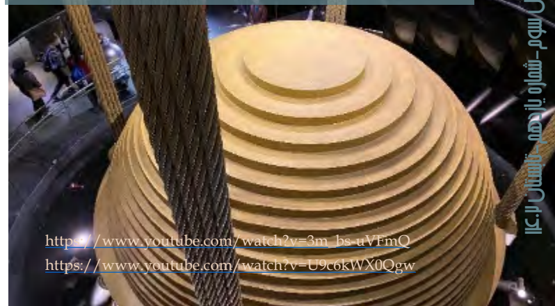
شکل ۶ - تصویری از یک جاذب ارتعاشی استفاده شده در برج 101 Taipei. برای درک بهتر به ویدئو زیر نگاه کنید.
